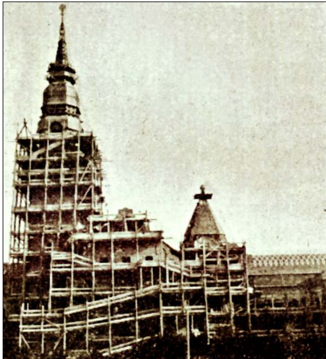
Gradska kuća pod skelama („Gradska kuća subotičko čudo”)
